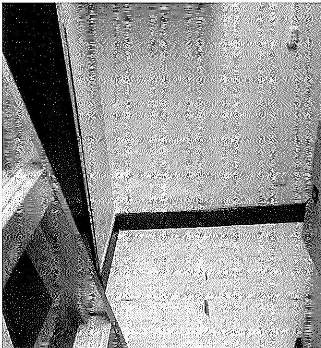
Imágenes donde se muestra la humedad en paredes e incluso en material en paredes como madera y carton.
