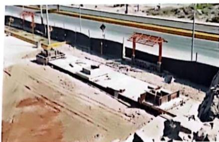
VACIADO DE VEREDA Y BANCAS EN PLATAFORMA 01
