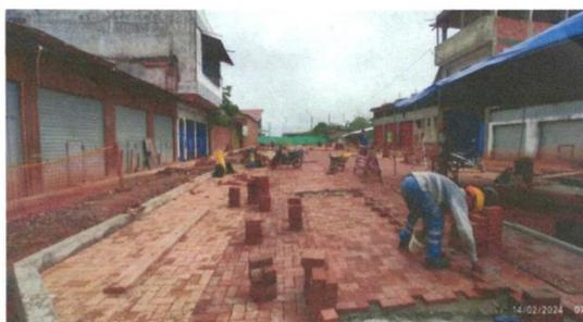
02.01.02.04 PISO DE ADOQUIN DE ARCILLA HIDROFUGO DE 2.5X10X20CM ASENTADO SOBRE LOSA DE CONCRETO CON MORTERO
